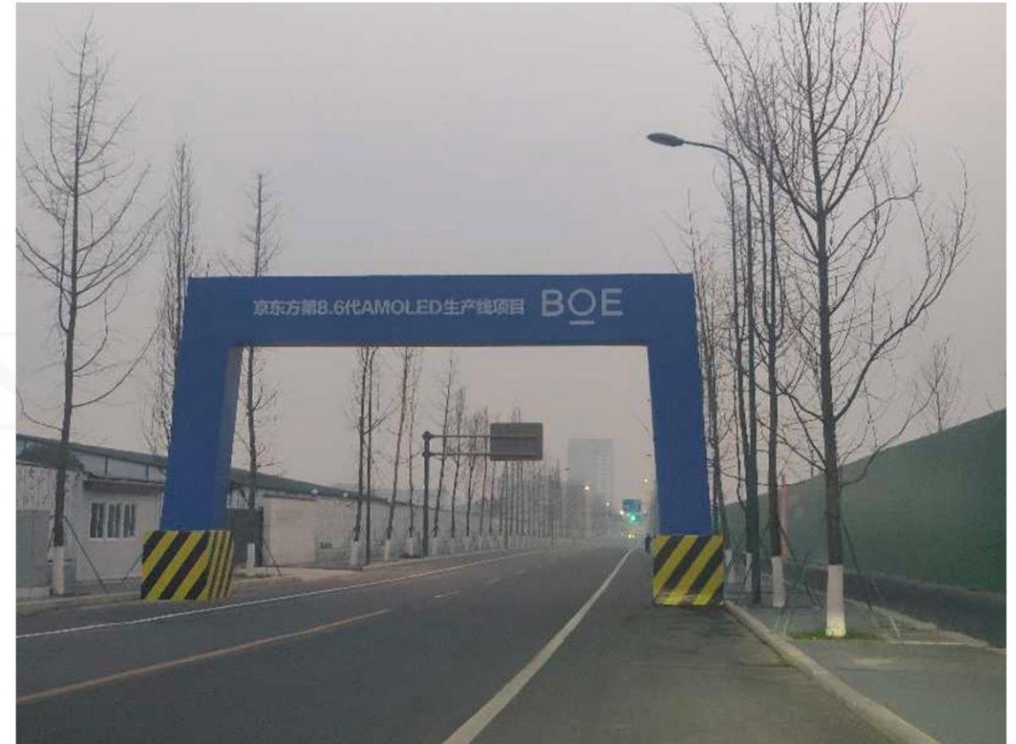
Chengdu B16 8.6G IT라인 공장 건설 현장
